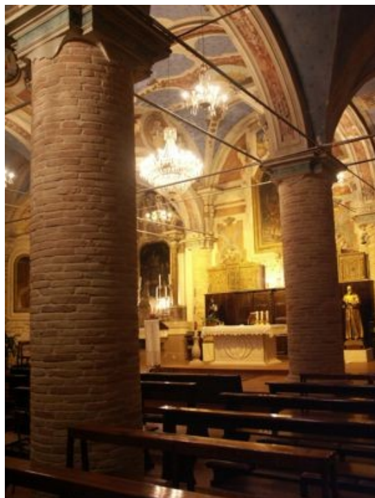
Chiesa di Castelbasso: interno
